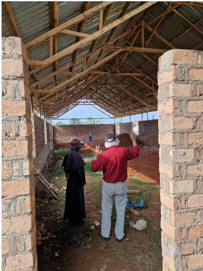
Nsimi school met fr Antidius met enorme eetzaal in aanbouw
